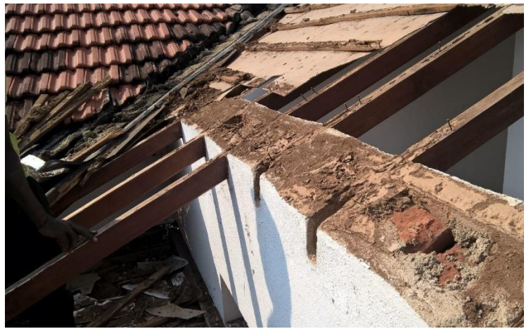
Bilder fra reparasjon av taket etter termitt angrep på Childrens Corner på Sri Lanka
